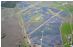
Photovoltaikparks „Sol“, Portugal Standort: Süd-Portugal Kapazität: 48,9 MWp Inbetriebnahme: August - Dezember 2019
