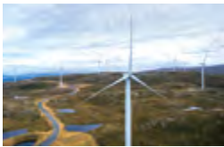
Windpark „Tesla“, Norwegen Standort: Süd-Norwegen Kapazität: 150 MW Inbetriebnahme: 2012-2018
