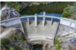
Kleinwasserkraftwerke „Sagres“, Portugal Standort: Portugal Kapazität: 102,7 MW Inbetriebnahme: zwischen 1951-2006 (21 Anlagen)
