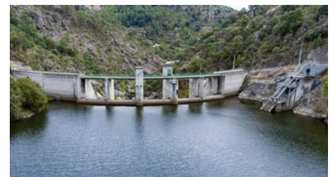
Wasserkraftanlage Sagres, Portugal 21 Anlagen in Nord- und Zentralportugal Inbetriebnahme zwischen 1951 und 2006
